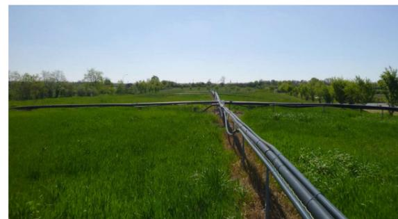
Réseau de biogaz sur l'ISDND en post-exploitation
